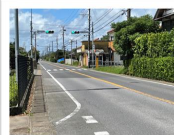
注意喚起等が施されていない学校に面した県道
